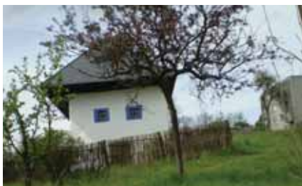
Objekt po oprave - pohľad čelný
