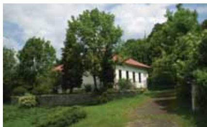
Turistická ubytovna (strecha po nátere)
