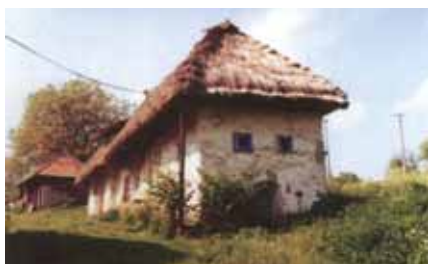
pohľad pred generálnou opravou
