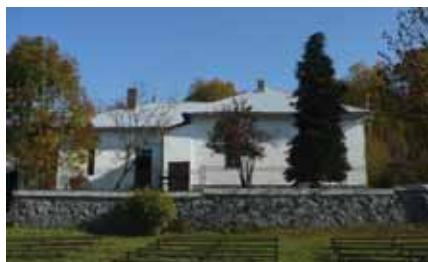
Turistická ubytovna (strecha pred náterom)
