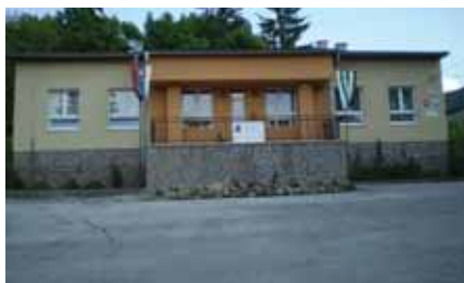
Kultúrny dom po rekonštrukcii - pohľad čelný
