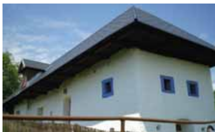
Objekt po oprave - pohľad južný
