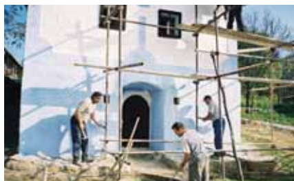
Rekonštrukčné práce - atypické ornamentey čelnej steny
